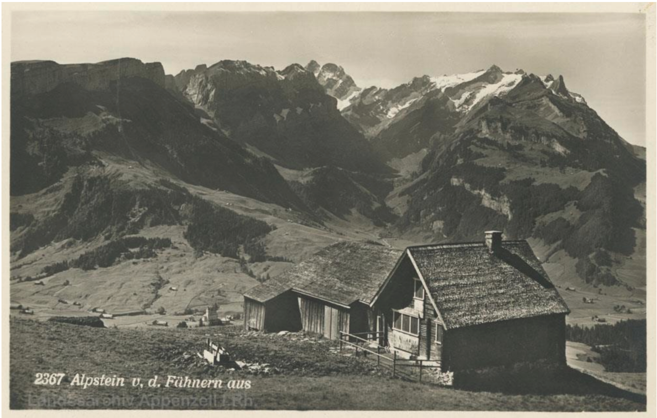
Fähneren 10, Guggeier, Brülisau, Wohnhaus mit Gaden Struben Sepp Aufnahme vor Brand 1963 Quelle: Landesarchiv Appenzell Innerrhoden
